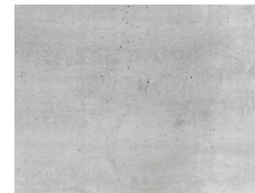
Elementtreppen Beton sichtbar
